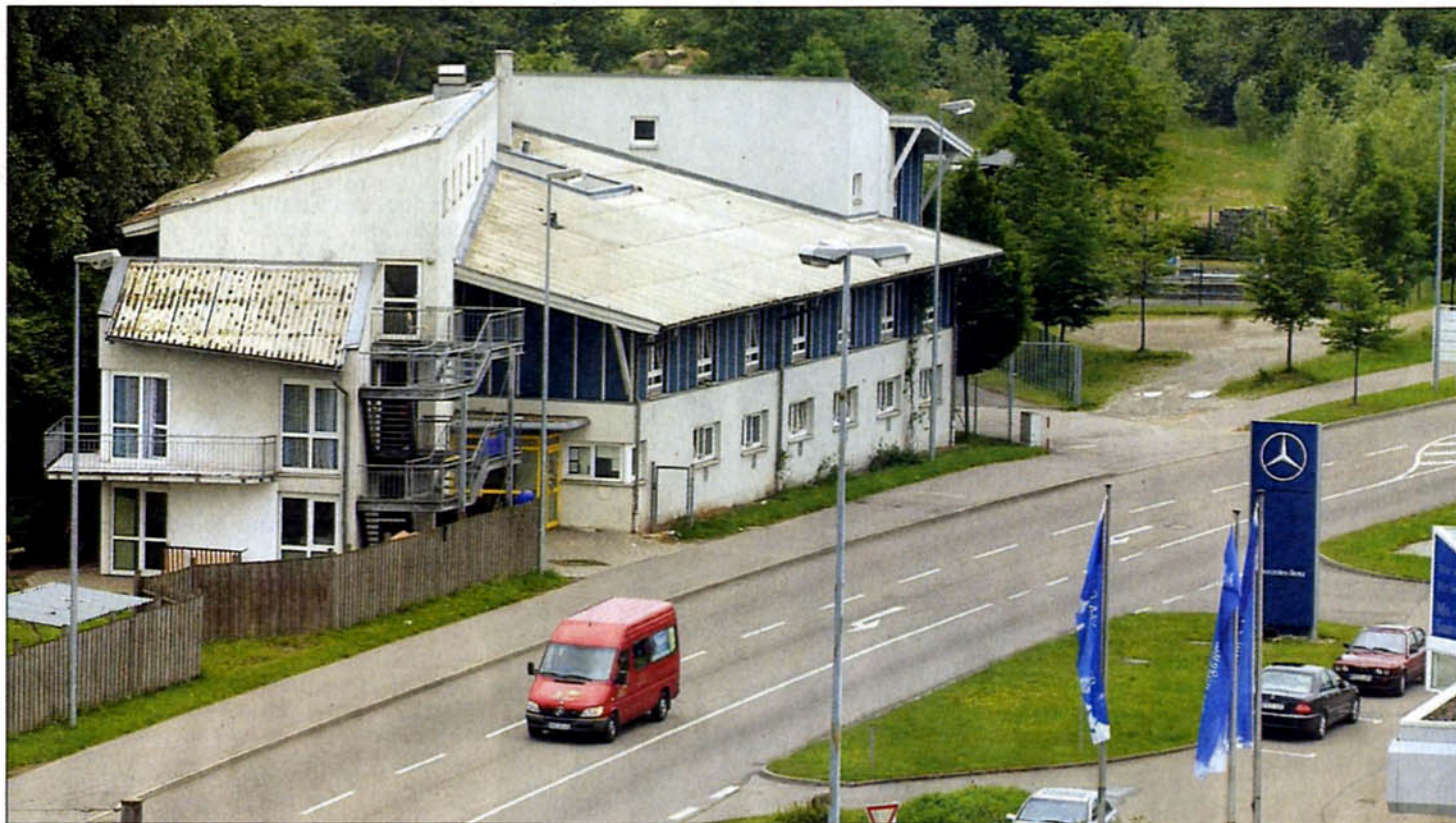
Statt in ein Bordell wird das ehemalige Asylbewerberwohnheim an der Stuttgarter Straße in ein Hotel garni umgewandelt.
